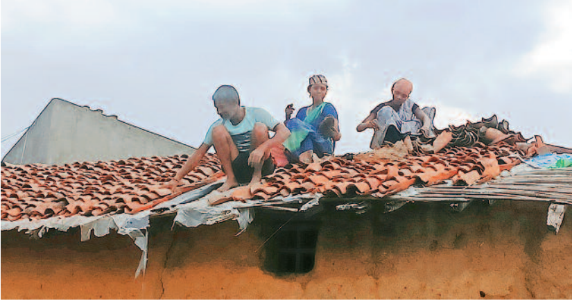
बंगोली। बरसात के पहले गांव देहात में छानी याने खपरेल की मरम्मत का कार्य शुरू हो गया। ग्राम मुरा में एक ग्रामीण अपने खपरेल ठीक कराने में जुट गया है। ताकि बारिश होने पर पानी नीचे न गिरे।
